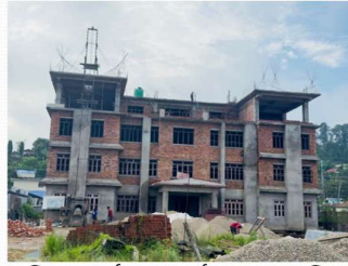
जिसस/पुर्वाधार कार्यालय भवन सिन्धुली
